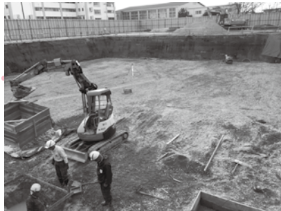
西中学校工事の様子
