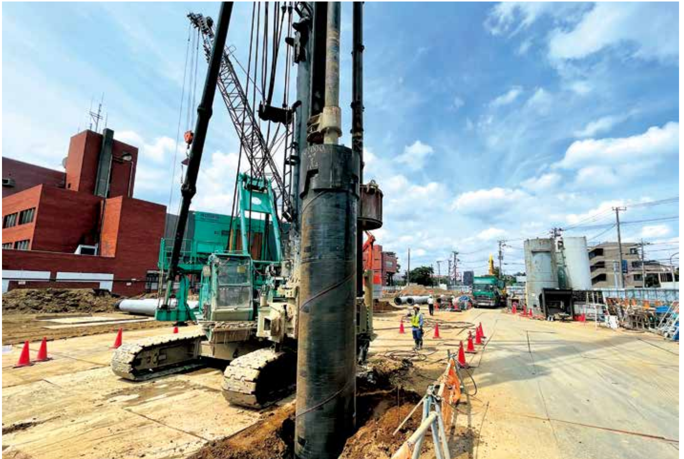
四街道市新庁舎建設工事の様子
