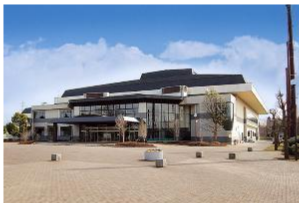
総合公園体育館
