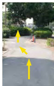
スピードが出ないように工夫された道路
