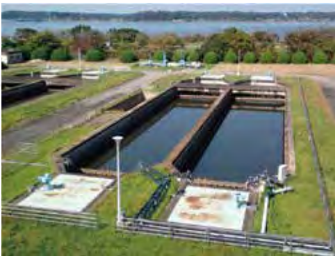
●取水場(印旛取水場)
