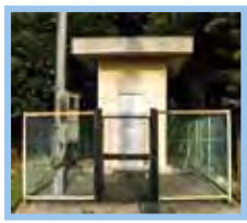
井戸ポンプ室
