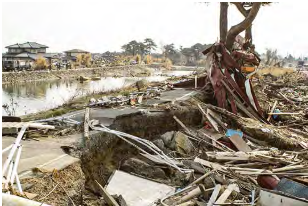
2011年（平成23年）東日本大震災の被害の様子（宮城県）
