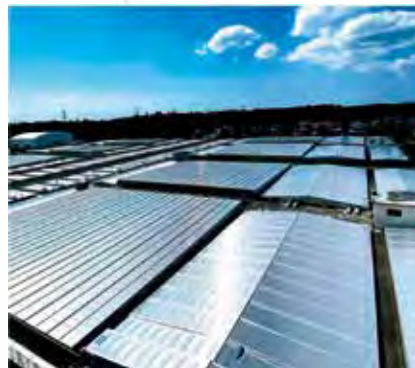
●沈でん池(柏井浄水場)
