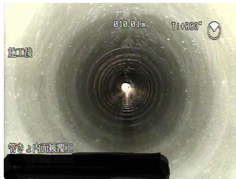
管更生後の下水道管の内部
