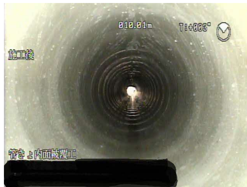
管更生後の下水道管の内部
