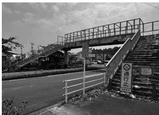
みそら歩道橋
