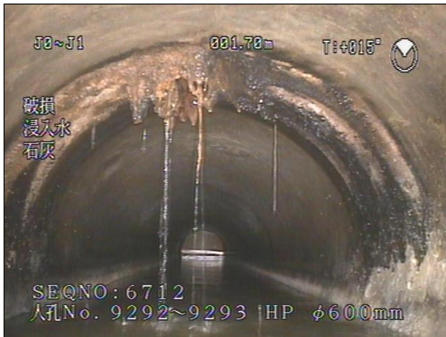
下水道管の内部(破損、侵入水)
