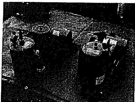
写真⑤ 浄化槽ポンプ交換
