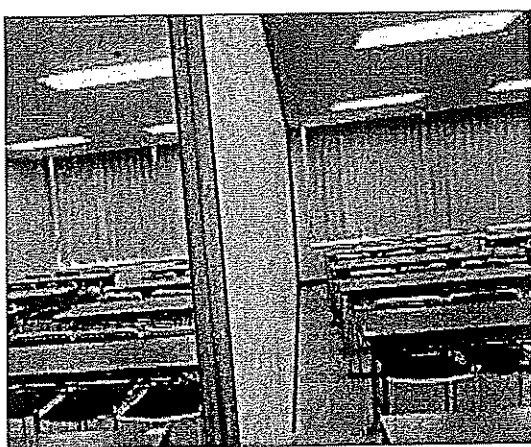
部屋を仕切っているパーテーション。(赤線の表示) 防音仕様ではなく、吊り下げ方式のため、隣同士の「音」が漏れ聞こえる状態。
