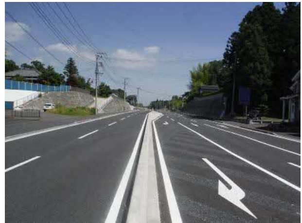
完成した(都)3・3・1号山梨臼井線1工区
