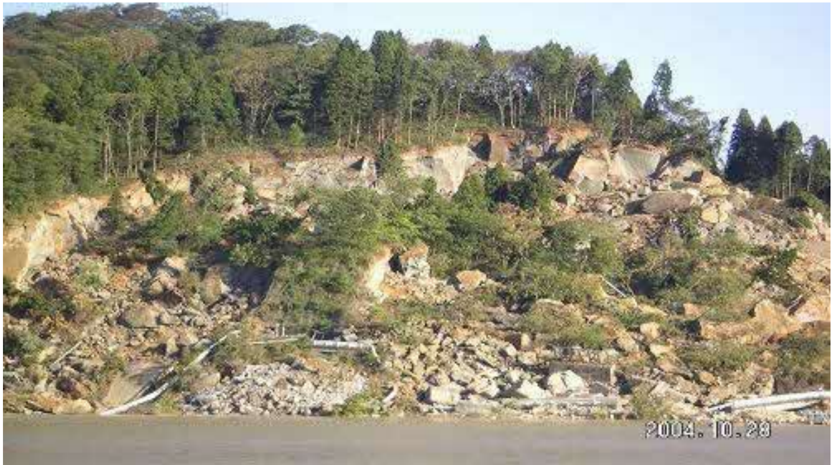
土砂災害(中越地震)
